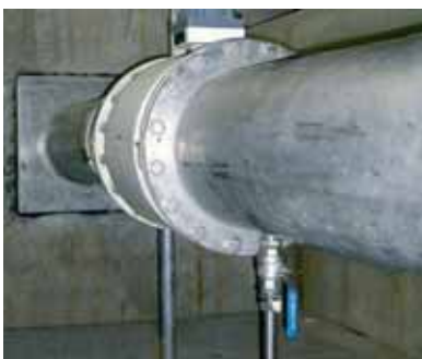
Putkianturilla voi korvata kustannus- tehokkaasti vanhan virtausmittauksen.
